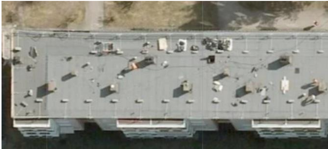
Bilde 1: Flyfoto fra 2009 som viser at blokk med leggemønster 2 blir tekket om.
