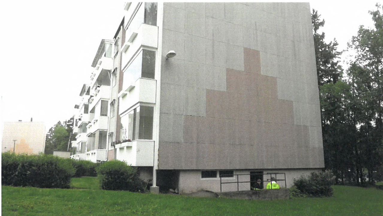
Foto 9: Gavl sør i Bølerlia 127-131. Terrenget heller inn mot langsidene.
