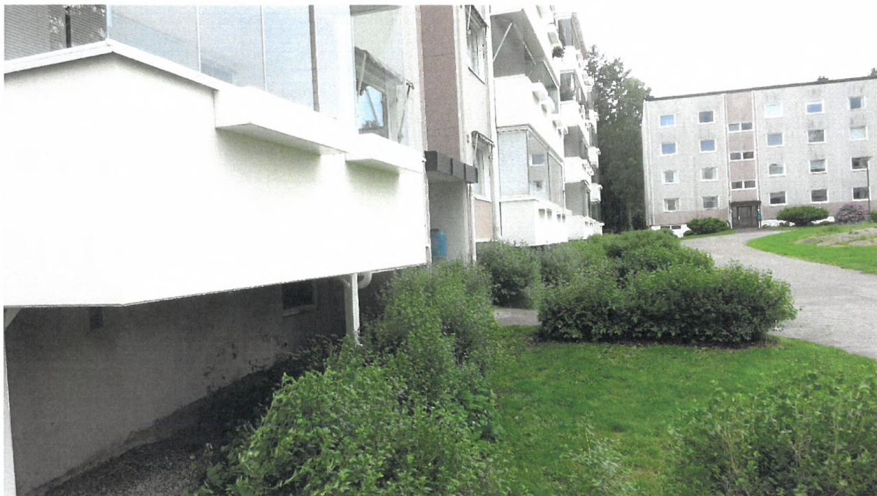
Foto 11: Bølerlia 127-131, langvegg mot øst, sett fra nordenden (utenfor 131). Beplantning langs fasaden. Ingen spesielle tiltak for å etablere terrengfall ut fra bygningen.
