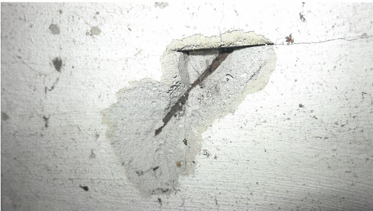
Foto 22: I et av kjellerrommene var det hugget spor inn i kjellerytterveggen. Her er det et sjikt med porebetong (Siporex). Det er en form for innvendig isolasjon av veggene, hvilket er gunstig.
