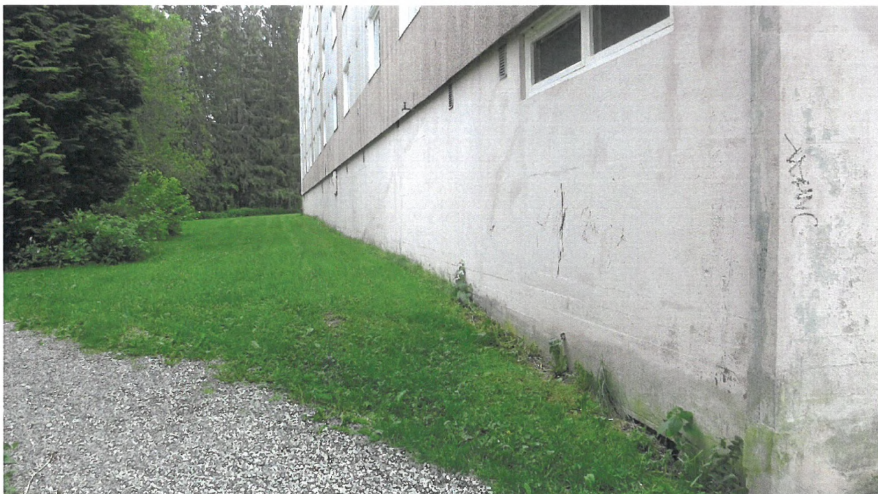
Foto 10: Bølerlia 127-131, langvegg mot øst. Gressplen heller svakt inn mot kjellervegg også her.
